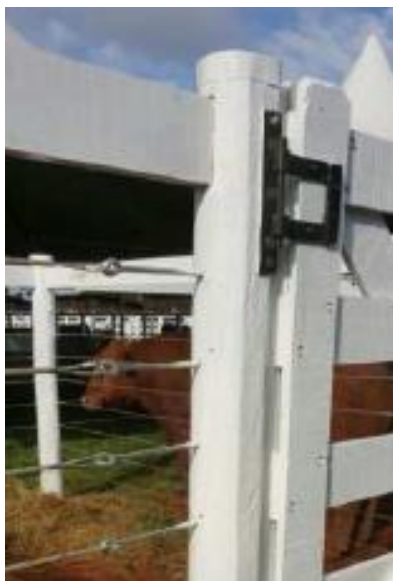
FOTO 04 – Detalhe estirantes e encaixa da viga com os mourões
