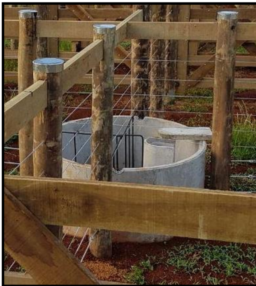
FOTO 05 – Impermeabilização dos mourões
