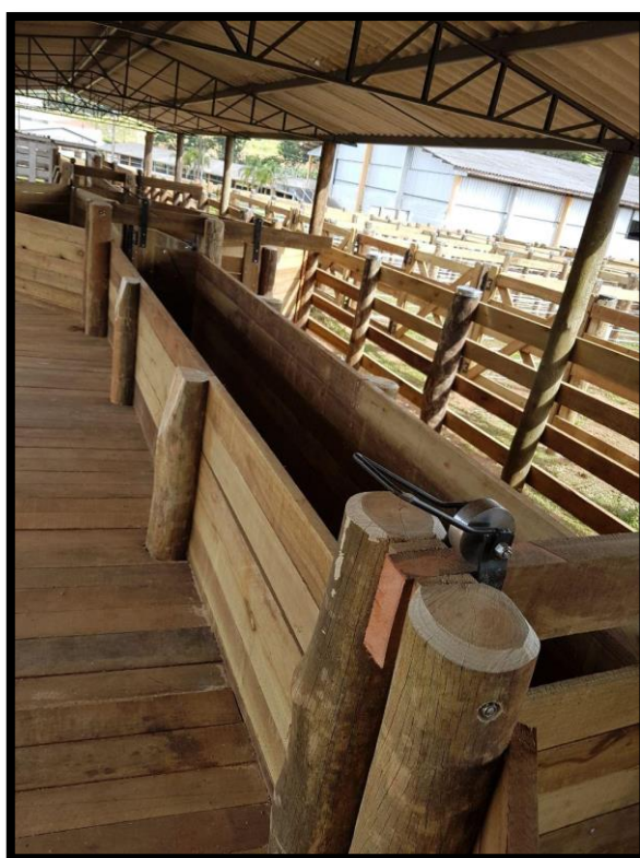
FOTO 09 - Detalhe dos portões de correr.
