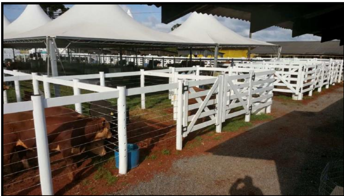
FOTO 12 - Detalhe das cercas de cordoalha e cercas e portões de cinco guias, (dobradiças dos portões e trancas com trava)
