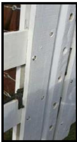
FOTO 03 - Detalhe dos tirantes deve ficar inseridos dentro dos mourões sem ponta para fora.
