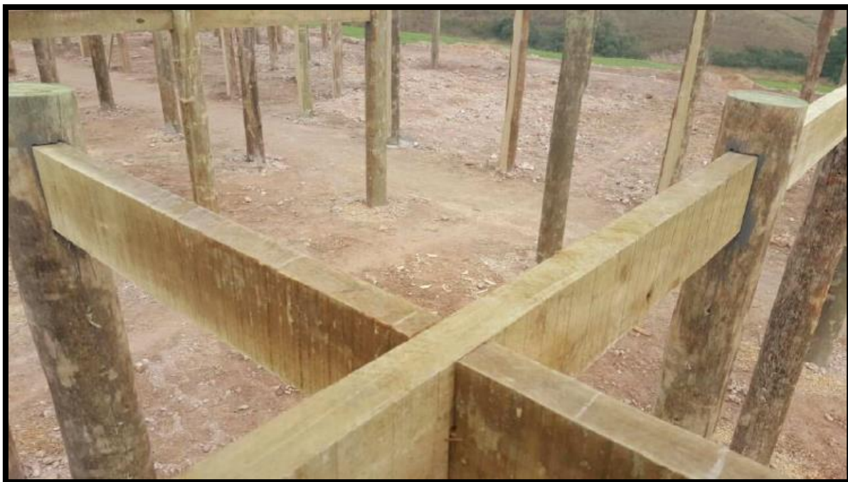
FOTO 11 - Detalhe dos encaixes das guias mourões
