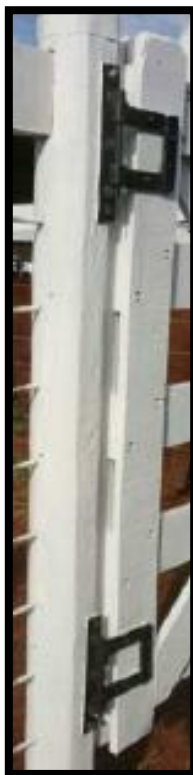
FOTO 07 - Detalhe do reforço nas dobradiças.
