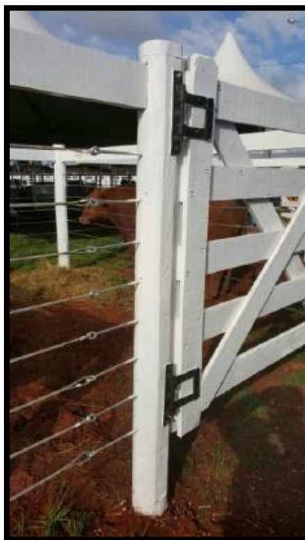
FOTO 06 - Detalhe das dobradiças dos portões e Tirantes.
