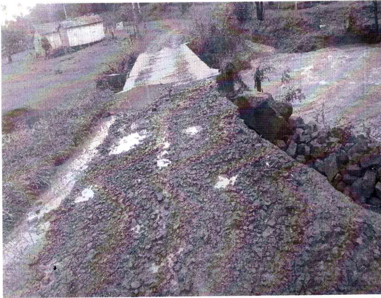
Fotos de estragos em Bueiros danificados pelo grande volume de água.
