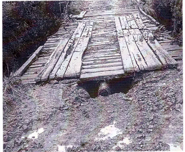
Fotos de estragos em Bueiros danificados pelo grande volume de água.
